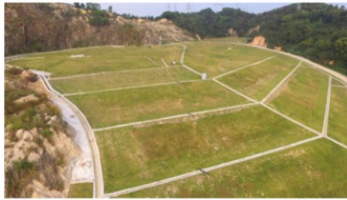
垃圾填埋场修复后
