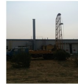
现场钻探地下水
